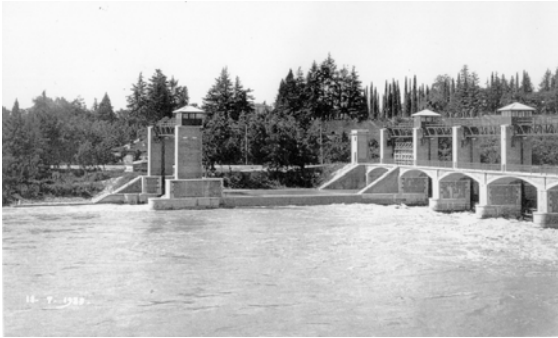
Chievo Dam Schleuse und Damm (Zustand vor Errichtung der StrafloMatrix™ Anlage)
