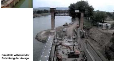
Baustelle während der Errichtung der Anlage
