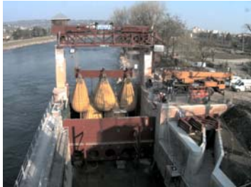
Belastungstest – Neues Hebezeug für Modul
