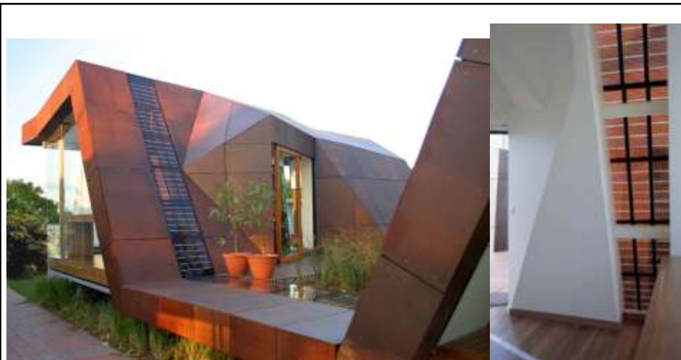
Gebäude-integrierte photovoltaische Glassfassaden aus von Dyesol.
